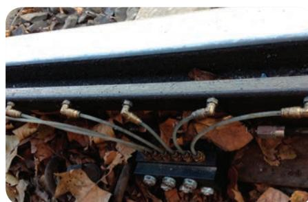
Смазочные материалы или фрикционные преобразователи подаются в точку смазывания через высоконапорные шланги. Количество и расположение каналов определяется на месте, чтобы обеспечить контакт колёс со смазочным материалом.
