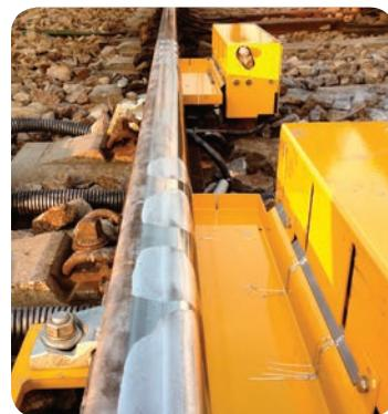
Одномагистральное устройство впрыска (SLID) наносит фрикционный преобразователь после прохождения поезда перед следующим поездом. SLID может устанавливаться снаружи или внутри рельса, и наносит преобразователь без контакта с рельсом или колесом.
